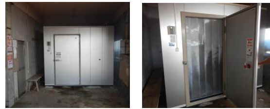
【住吉漁港内に整備した冷凍冷蔵庫】
