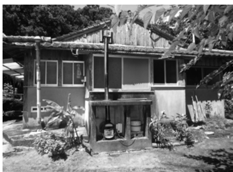
武田家住宅（仮屋）弘化3年築
