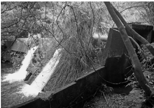
発電用取水ダム
