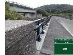
川脇橋橋梁補修工事 繰5-1工区
