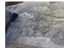
現和下之町石堂線法面応急工事
