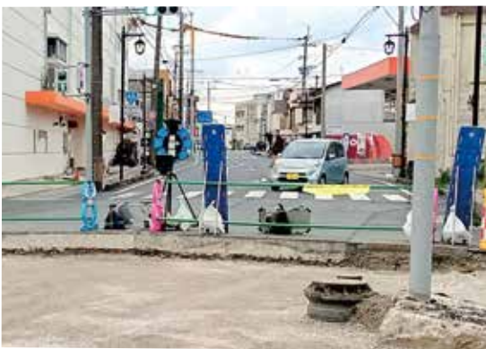
分厚い舗装の断面を見せる道路改修工事
