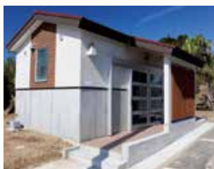
▲喜志鹿崎灯台に整備したトイレ
