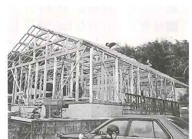
地元材を利用した建築中の大田さん宅(榕城中目)
