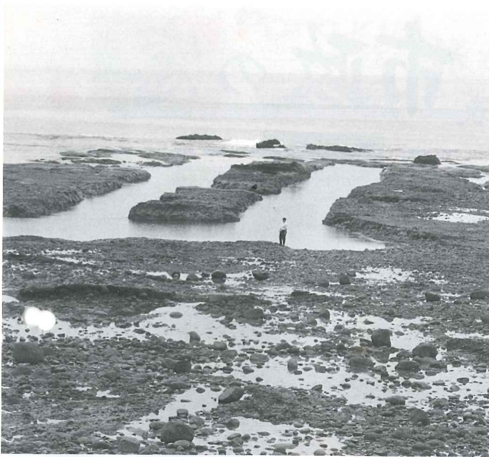
▲沖に向かって縦に数本伸びる養殖溝は巾5m、深さ2m。それを結ぶように横に掘られた排水溝は巾10m、深さ3m。
