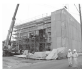
▲建設中の汚泥再生処理センター
