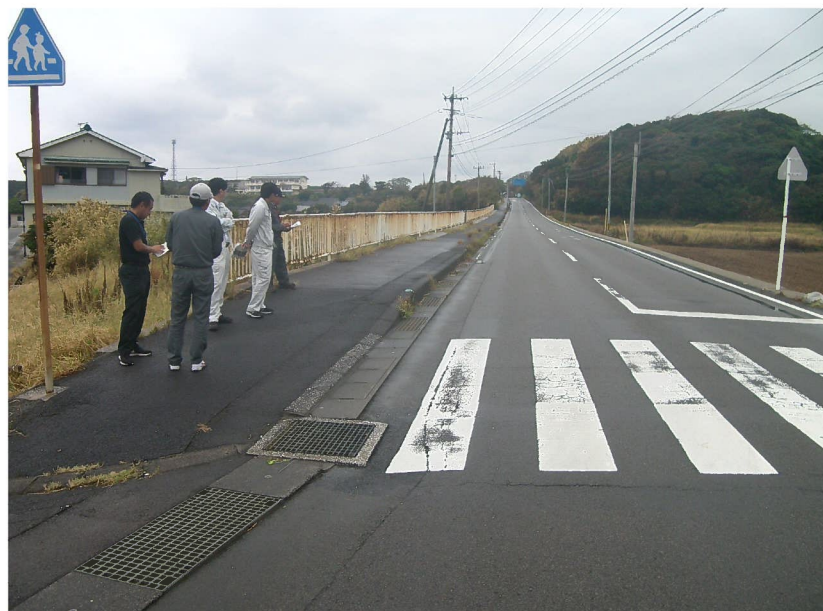
H30合同点検 実施状況
