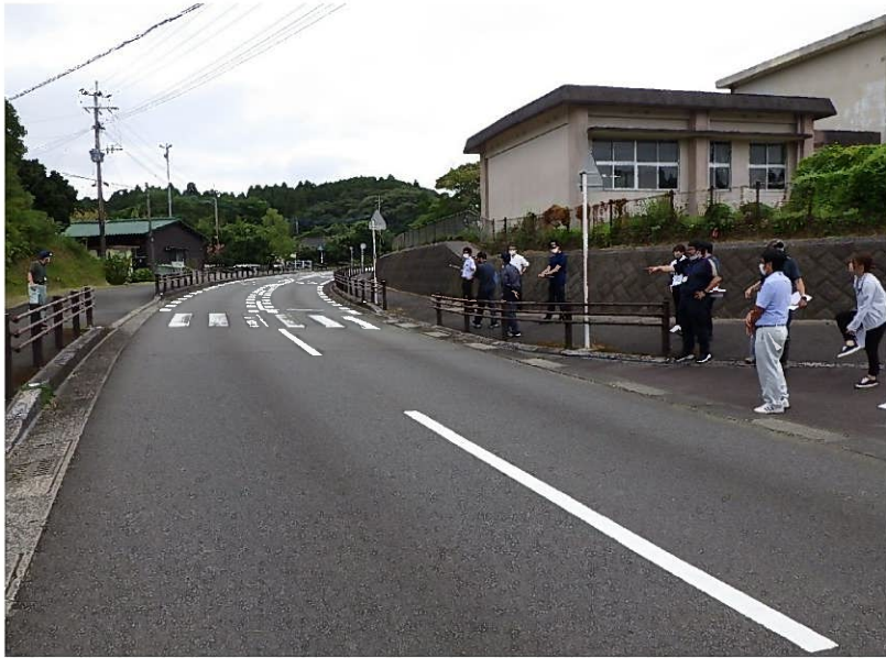
R3緊急合同点検 実施状況
