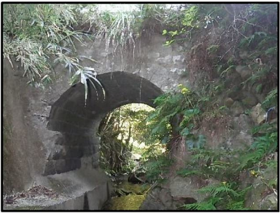
古屋橋（石橋） 中之町古屋川／昭和 18 年架設
