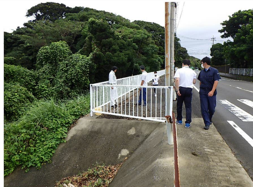
R2合同点検 実施状況
