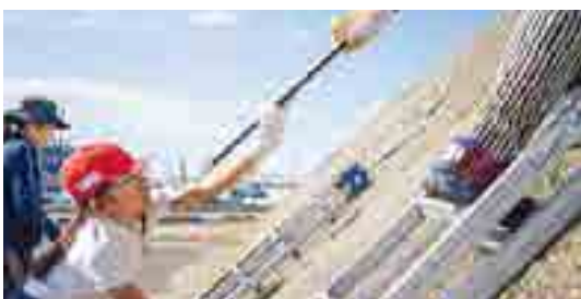
シリコンが塗られた板を渡す
