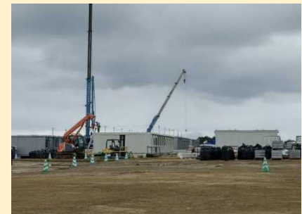
仮設宿舎工事
