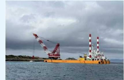
基礎捨石工事
