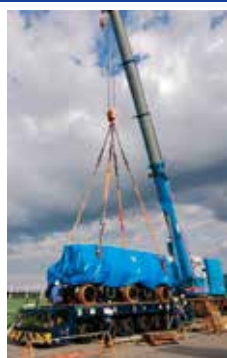
▲島間港に到着したドーリー
