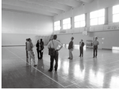
▶伊関小学校 体育館の雨漏り、舞台下の木製の扉の補修、改善
