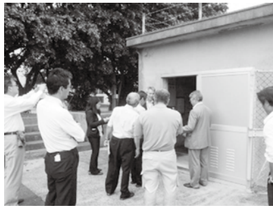
▲種子島中学校 プールのろ過器、塩素剤連続注入装置の修繕を要望
